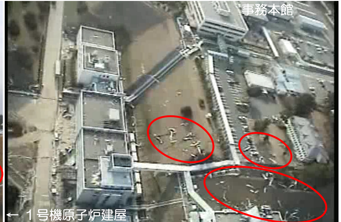
1号機原子炉建屋北側
