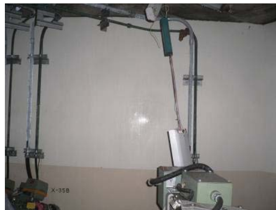
使用済燃料プールを支持する壁
