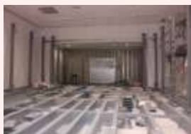
ゲートモーター室床鉄骨組状況
