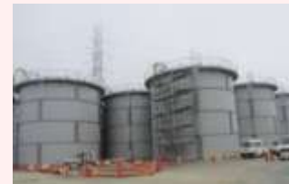
処理水受け用タンク
