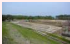
保護土工を実施中(2槽目) [2012/5/24撮影]
