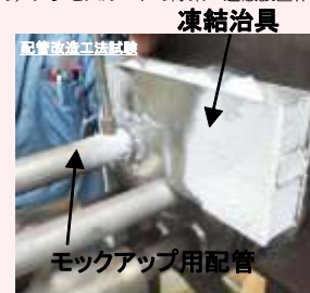
※写真は凍結工法の例 モックアップ試験の様子
