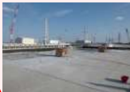
屋上コンクリート撤去状況
