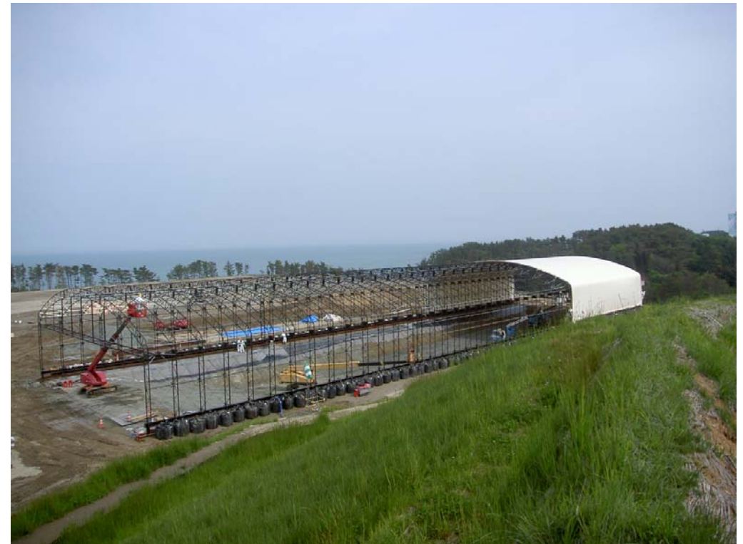
1槽目 [H24.5.24撮影] 雨養生用の仮設テントを組み立て中
