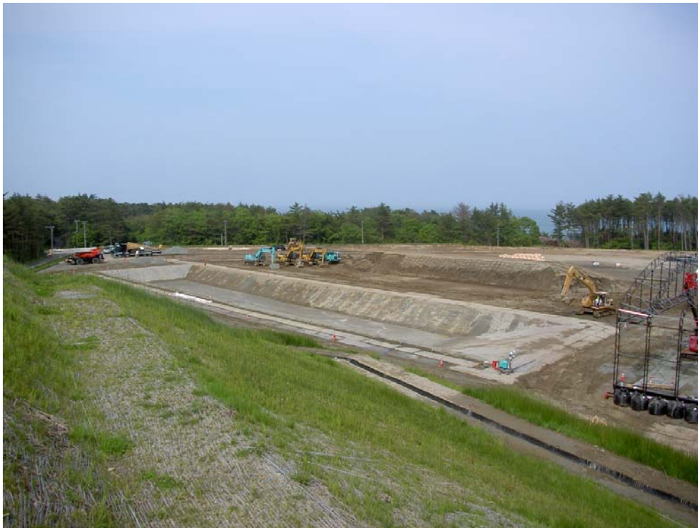
2槽目 [H24.5.24撮影] 保護土工を実施中
