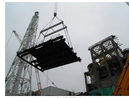
図 6 : 4号機 使用済み燃料プール防護構台設置の様子
