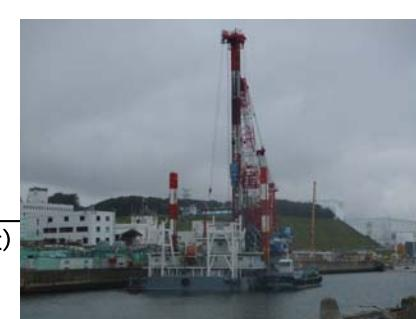
図4：遮水壁先行削孔作業
