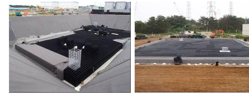
図2：地下貯水槽設置状況
