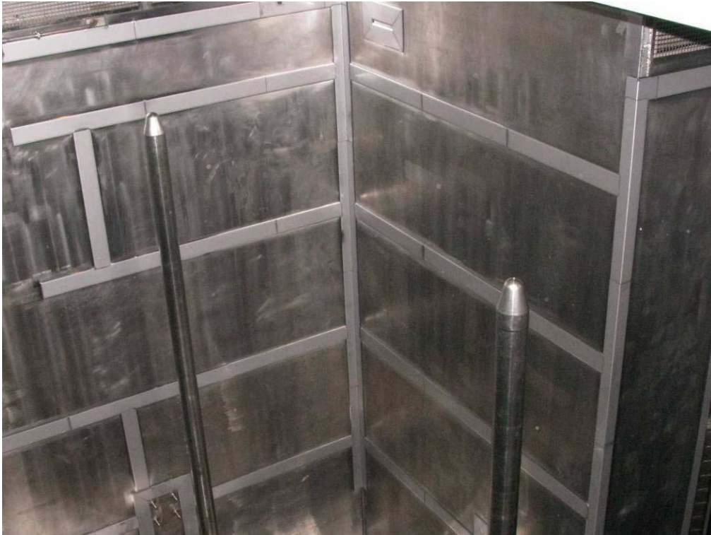
その他〔施工写真〕 PWR 原子炉キャビティ 樹脂コーティング施工例
