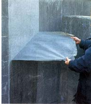
乾燥した塗膜の剥離
