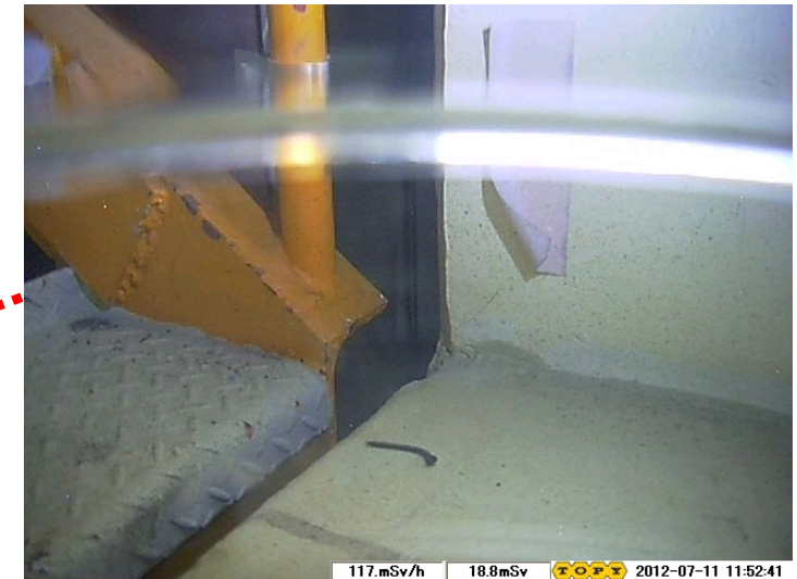
トラス室入口
