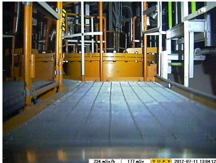
南東マンホール
