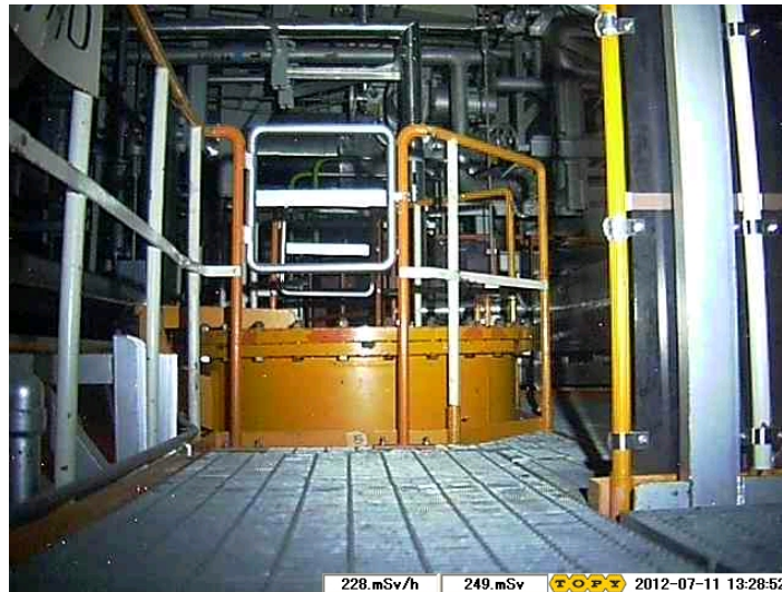
北側マンホール
