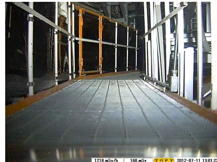
グレーチング状況
