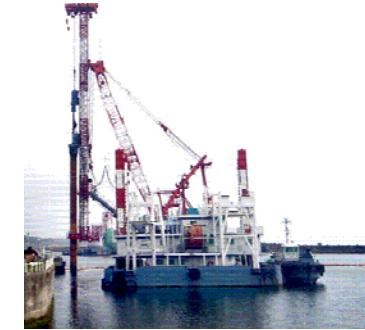
図2：遮水壁先行掘削作業状況
