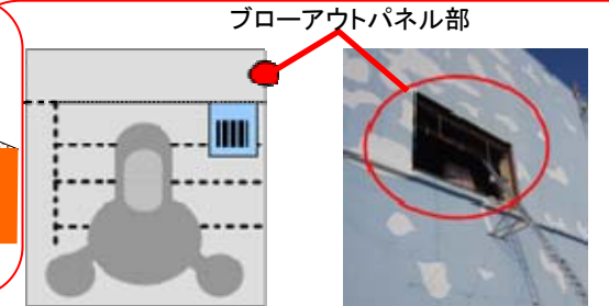
図6：2号機原子炉建屋ブローアウトパネル開口部
