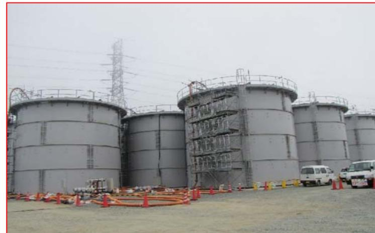
(既設のEエリアタンク 合計容量：8,000トン) (リプレース後 合計容量：41,000トン)
