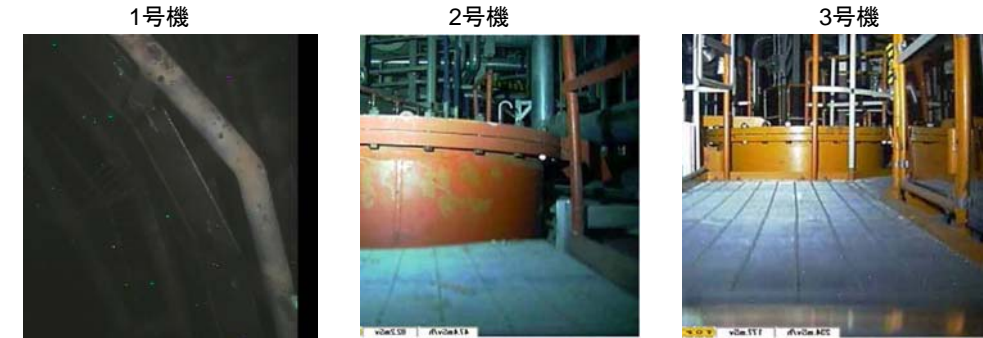
トラス室内の手すり・マンホール塗装の腐食状況の違い
