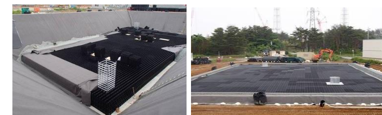
＜地下貯水槽設置状況＞
