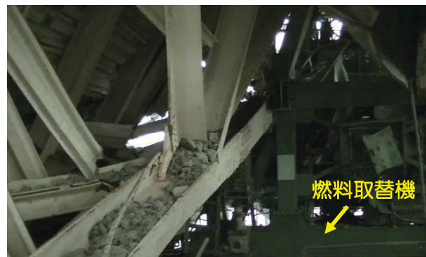
バルーンからみた北東方向の写真
