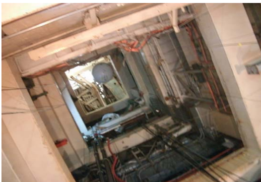
バルーン機器ハッチ内浮遊状況 (真上を見上げた画像)
