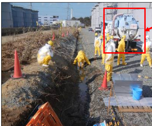
吸引車による漏えい物回収作業の様子
