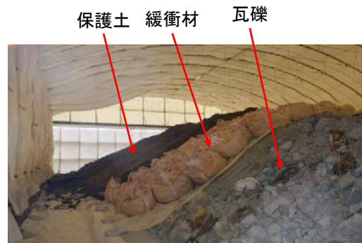
1槽目内部の状態(11/1)
