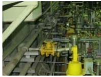
狭隘な場所での解体作業
