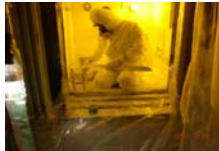
核燃料物質等で汚染された場所での解体作業
