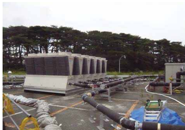
冷凍機 配管接続状況
