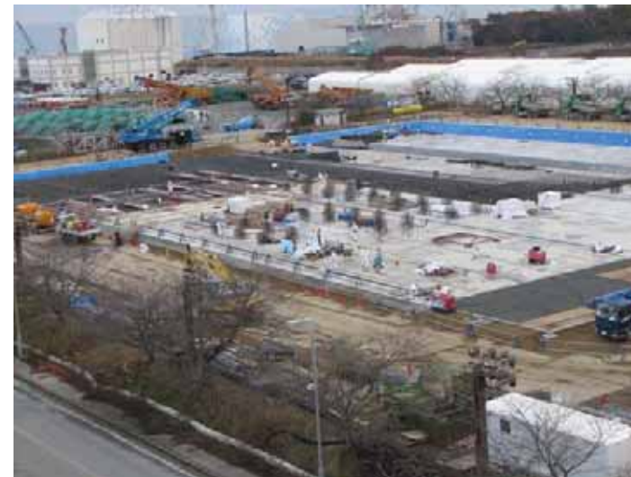
②工事の状況(12/3)
