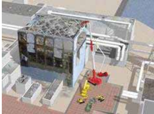
原子炉建屋上部のガレキ撤去 (撤去前の作業イメージ)
