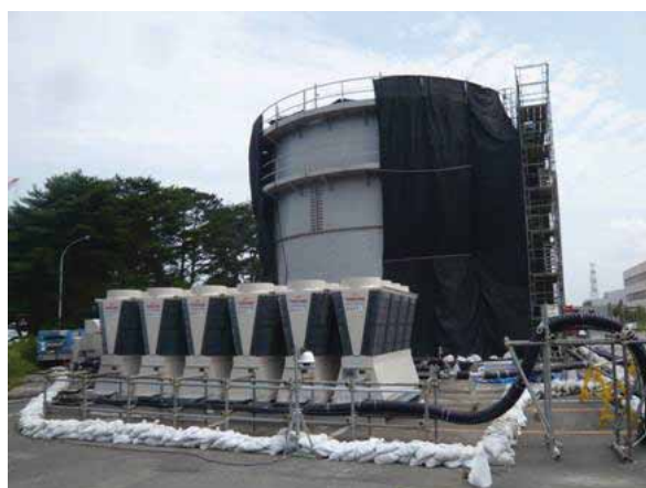
処理水バッファタンク (奥)、 冷凍機 (手前)
