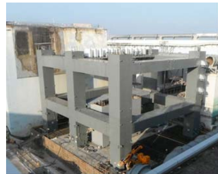
図3：鉄骨建方2節目完了(2/28撮影)
