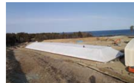
図7：2槽目の設置状況(2/26撮影)
