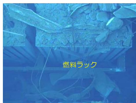
燃料ラックの状況
