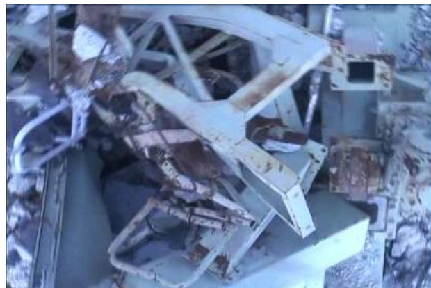
東側エンドトラック
