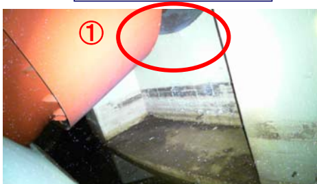
ベント管スリーブ端部
