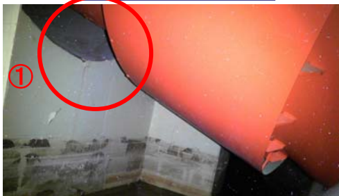
ベント管スリーブ端部
