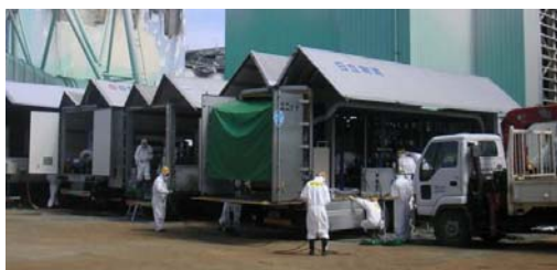
塩分除去 逆浸透膜(RO)装置
