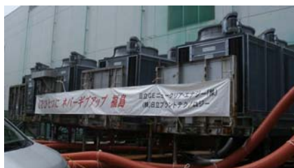
使用済燃料プール 循環冷却装置
