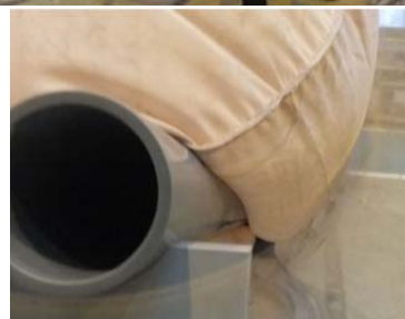
干渉物への閉止材のまわりこみ状況
