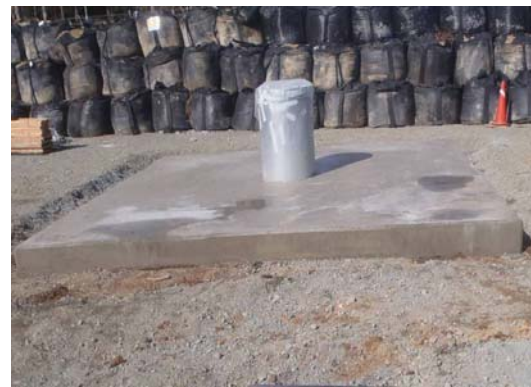
No.9揚水井（B系統）設置完了
