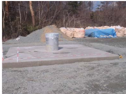
No.11揚水井（C系統）設置完了
