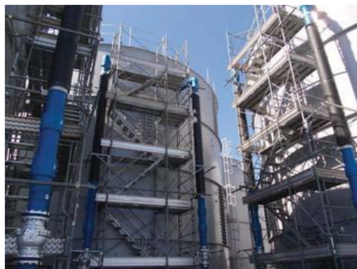
一時貯留タンク設置状況
