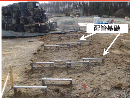
(B系統) 配管基礎設置状況
