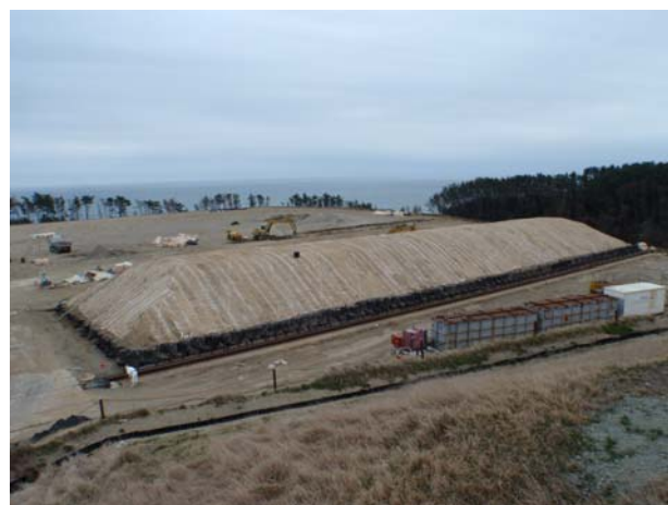
1槽目の状況 (3/27撮影)
