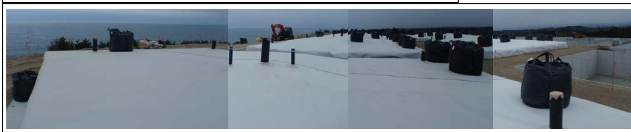
一時保管エリアTの状況 (3/27撮影)
