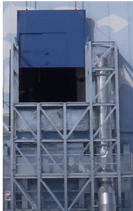
閉止パネル設置中
