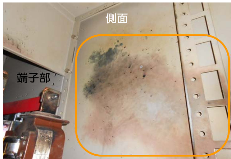
5Aユニット側面のアーク痕状況
