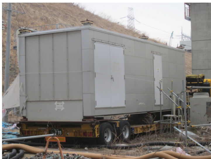
コンテナ側面 仮設3/4号M/C入口
