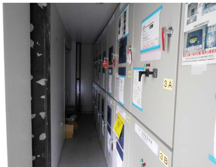
仮設3/4号M/C前面 (コンテナ内部)
