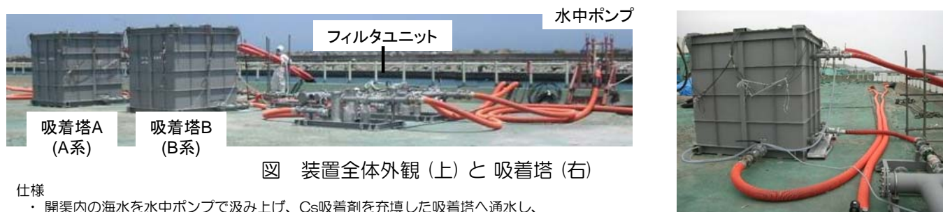
図 装置全体配置と水中ポンプ移設先
