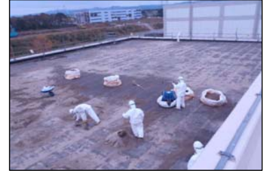
屋上コンクリート撤去
