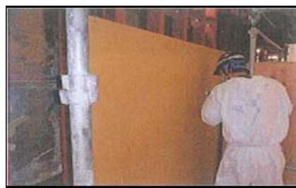
免震棟通信機械室壁遮へい
