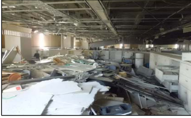
上階執務室（工事前）
