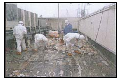
屋上コンクリート撤去
