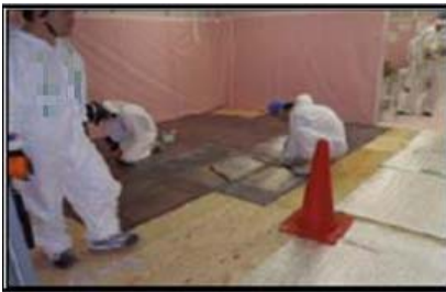
免震重要棟前休憩所床鉛遮へい
