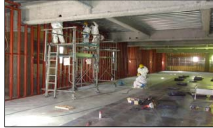
床・壁鉛遮へい
