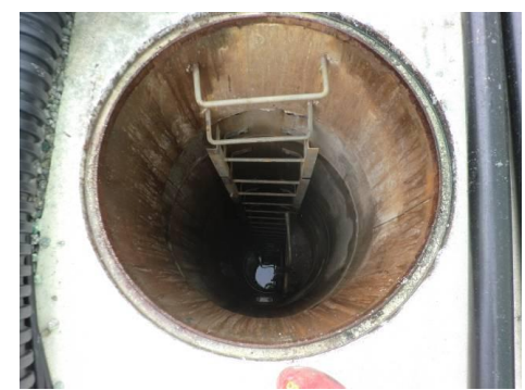
サブドレンピット内部
