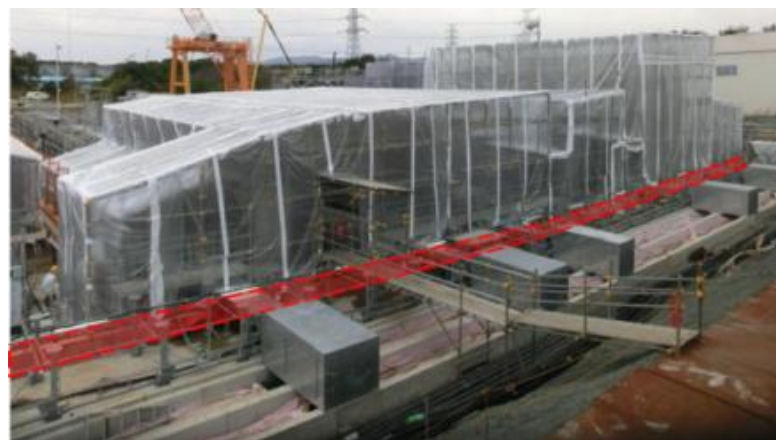
<多核種除去設備設置状況>
