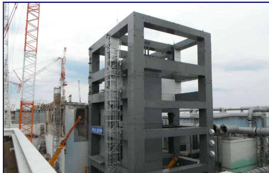
鉄骨建方進捗状況：平成25年4月10日（時点）
