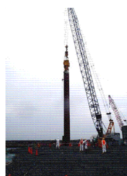
図2：遮水壁鋼管矢板打設
