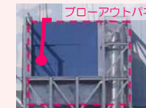
閉止パネル設置完了後
