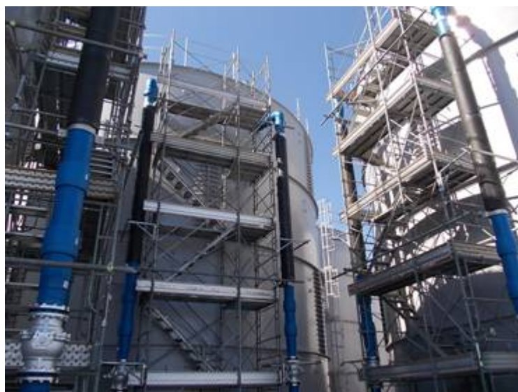
一時貯留タンク設置状況
