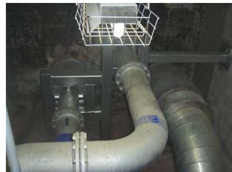
建屋接続部（奥：配管貫通部）
