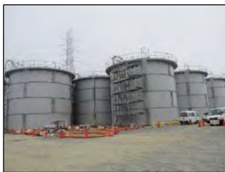
鋼製円筒型タンク
