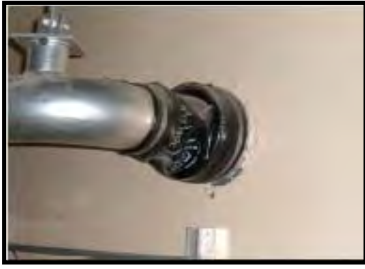
配管スリーブ貫通部
