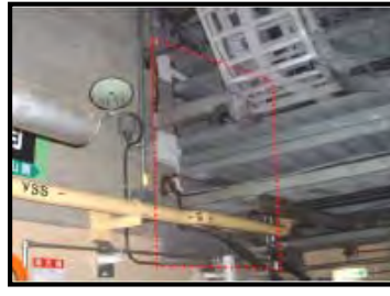
ケーブルトレイ貫通部 (トレンチ)
