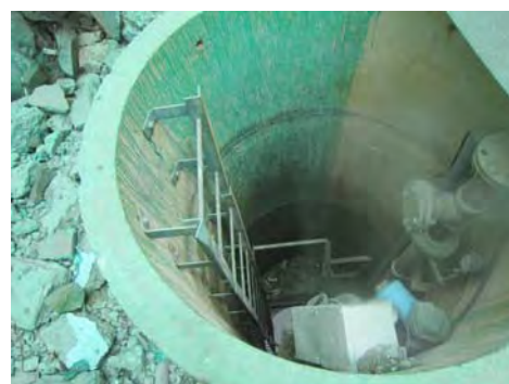
サブドレンピット内部（事故後）
