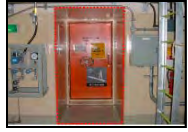
扉開口部 (建屋間ギャップ)
