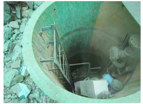
サブドレンピット内部（事故後）
