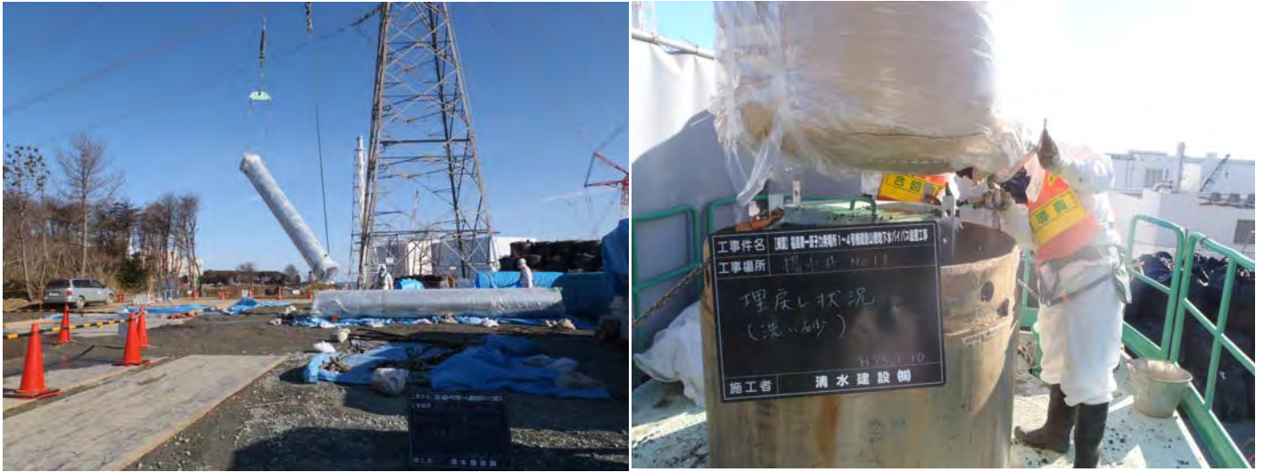
資機材の汚染防止対策
