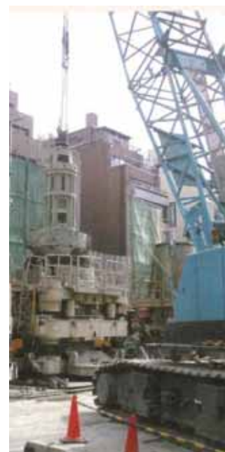
円形部の施工機械(CD工法)
