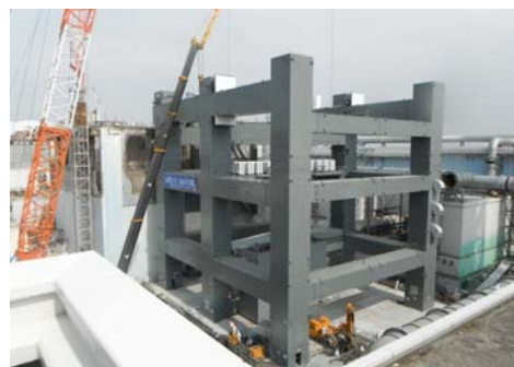
③ 第3節部分の完了（平成25年3月13日）
