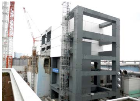
⑤ 鉄骨建方の完了（平成25年5月29日）
