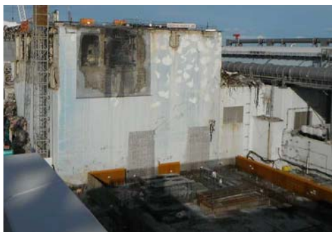
① 鉄骨建方 着工前（平成24年12月18日）
