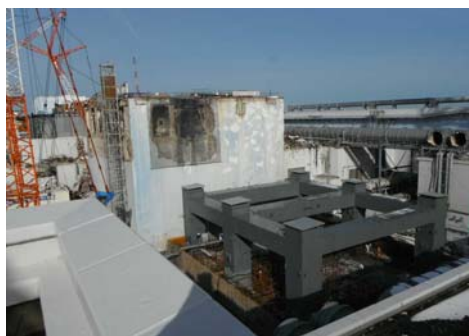
② 第1節部分の完了（平成25年1月14日）
