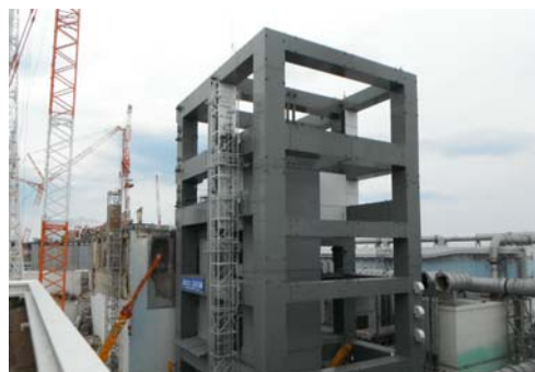
④ 原子炉建屋上部を除く鉄骨建方部分の完了 （平成25年4月10日）
