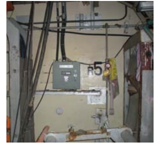
④ 西面（内壁）
