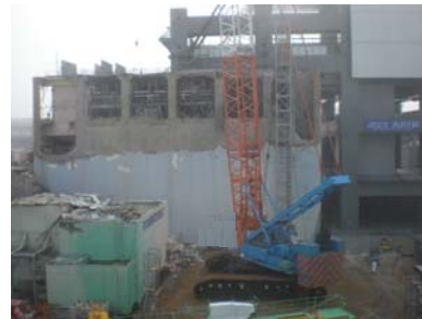
⑤ 西面（外壁）
