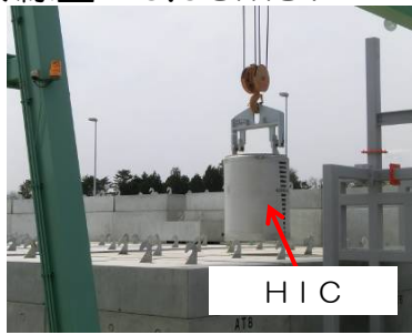
一時保管施設エリア
