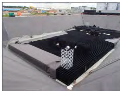
[地下貯水槽の構造(出典:東京電力)]
