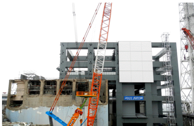
鉄骨建方完了 (5/29)
