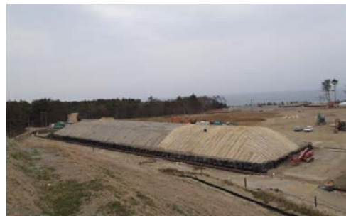
現場写真 (2槽目：3/25撮影)
