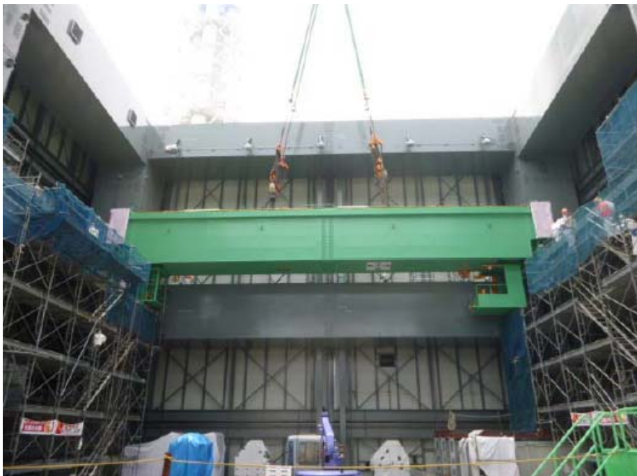
②天井クレーン部材上架
