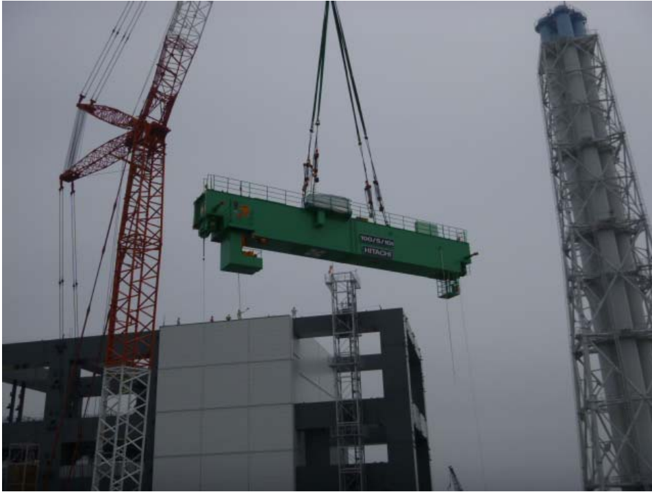
①天井クレーン部材吊り上げ
