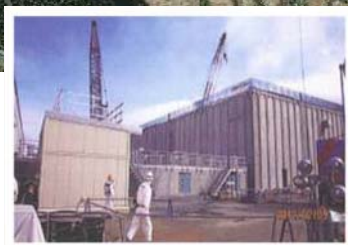
廃スラッジ一時保管施設
