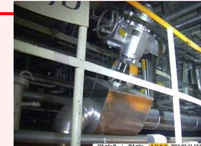
格納容器側状況
