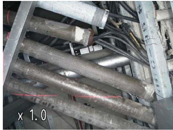
撮影箇所①天井状況
