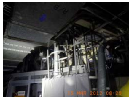
R/B1階上部の状況 (2号機の例)
