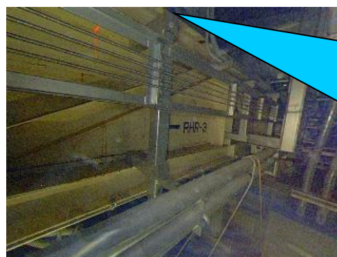
撮影箇所⑤壁面側(床上3.5m)
