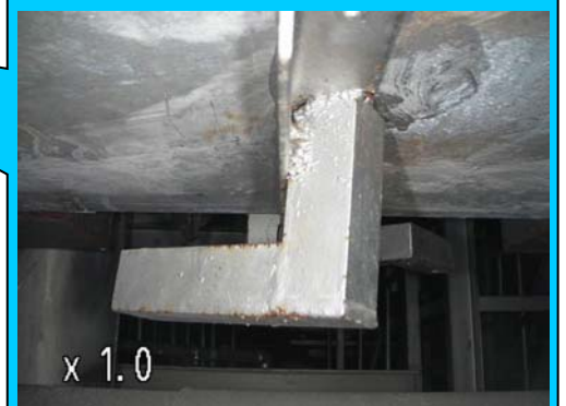
撮影箇所⑤壁面側上部隙間(床上4.3m)
