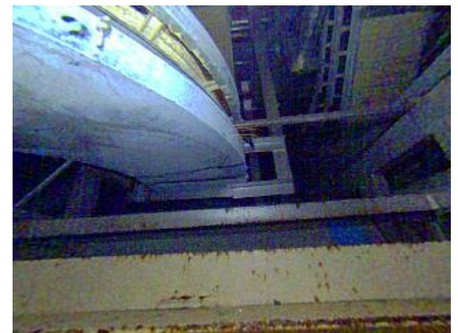
撮影箇所④壁面側上部(床上4.0m)
