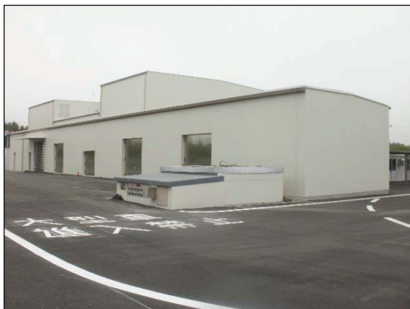
化学分析棟の外観 [地上1階、地下1階]
