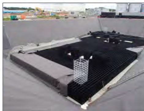
[地下貯水槽の構造(出典:東京電力)]
