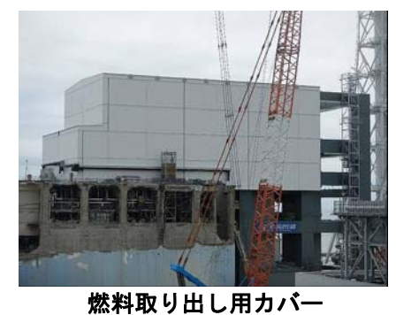
図5：4号機燃料取り出し用カバー設置状況
