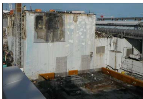
①鉄骨建方着手前 （平成24年12月18日）
