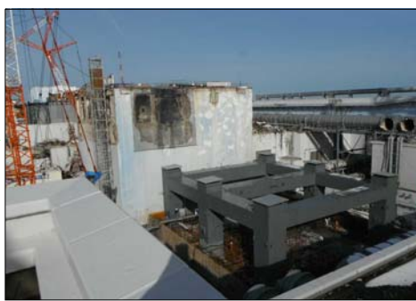
②第一節 鉄骨建方完了 （平成25年1月14日）
