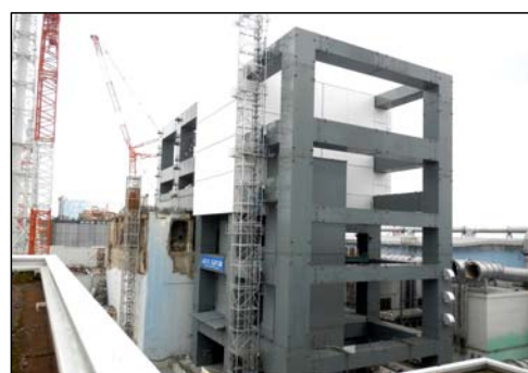
④鉄骨建方完了 （平成25年5月29日）
