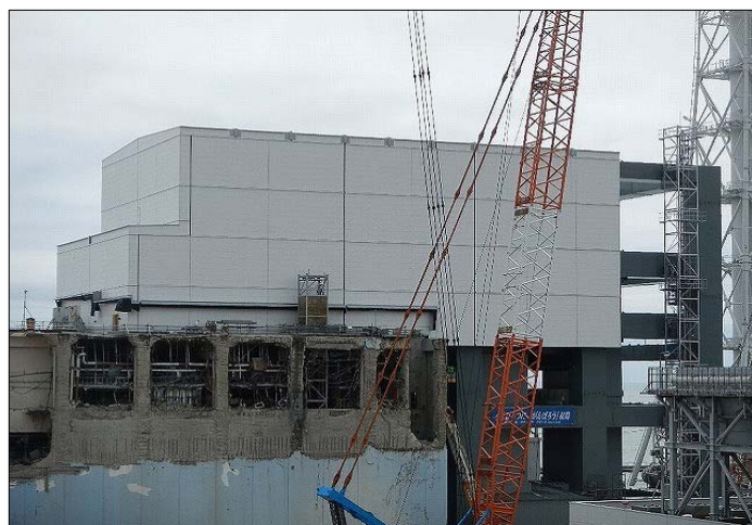
外壁・屋根パネル設置完了（7月20日）
