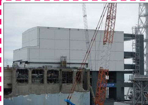
⑤外壁・屋根パネル設置完了 （平成25年7月20日）
