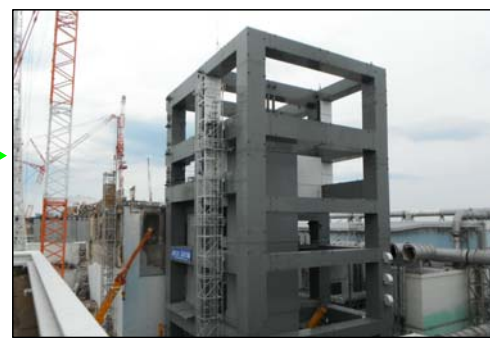
③原子炉建屋上部を除く鉄骨建方完了 （平成25年4月10日）
