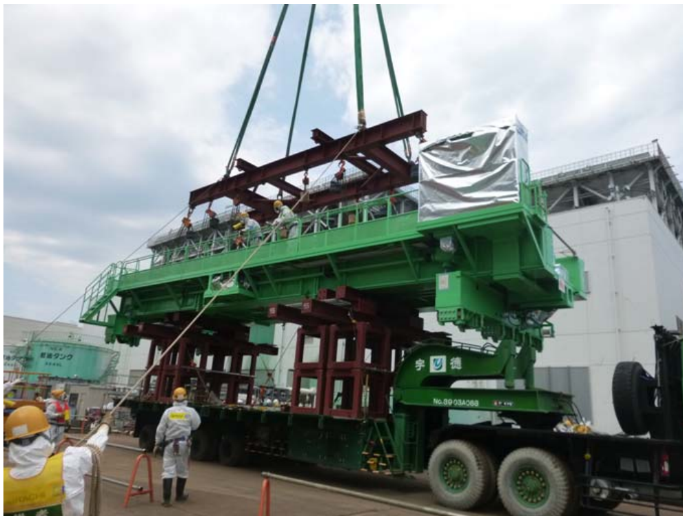
①燃料取扱機 部材上架準備
