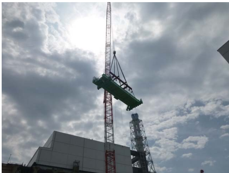
②燃料取扱機 部材吊り上げ
